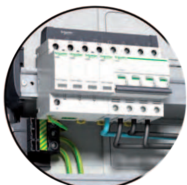
Ogranicznik przepięć 4P + iC60N 4P
