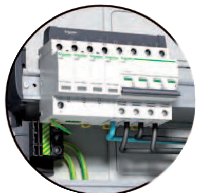
Ogranicznik przepięć 4P + iC60N 4P
