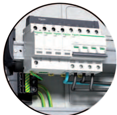
Ogranicznik przepięć 4P + iC60N 4P
