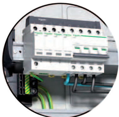
Ogranicznik przepięć 4P + iC60N 4P
